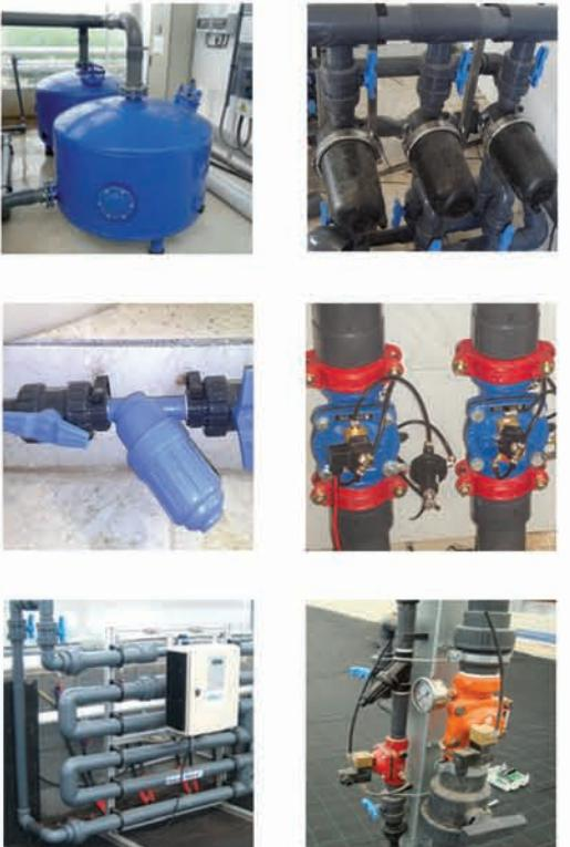
سیستم آبیاری قطره‌ای این شرکت در دو مدل کلی اتوماتیک و هوشمند قابل ارائه می‌باشد که در تمامی آنها از بهترین اجنباس و لوازم و با بهترین کیفیت استفاده می‌شود که شامل سیستم فیلتراسیون از نوع AZUD و لوله‌های اصلی و فرعی تقسیم آب و نوارهای آبیاری از نوع AZUD یا Eurodrip و سیستم تریپکود و ... می‌باشد.
